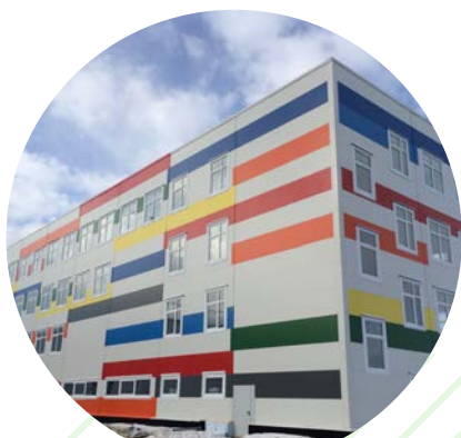
ЗАВОД "ИНКАБ". Г. ПЕРМЬ, УЛ. ВОДОПРОВОДНАЯ, 9А.
